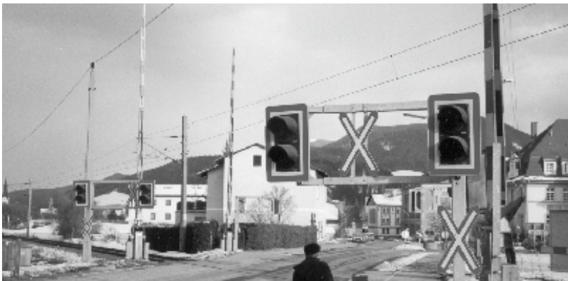
An diesem Bahnübergang könnte der Haltepunkt Leoben Kerpelystraße errichtet werden. Im Hintergrund kann man die HBLA erkennen.
