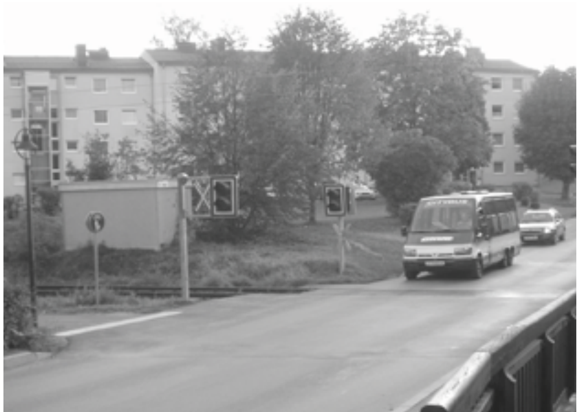
Trofaiach Kehrgasse: Ein kurzer Fußweg ins Zentrum, dichte Besiedlung in der unmittelbaren Umgebung und die Möglichkeit, eine Umsteigestelle zum Citybus zu schaffen, sind die Charakteristika dieses Haltepunktes, der im Bild links neben der Bahnübersetzung errichtet werden sollte.
